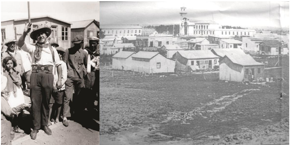
Figura 4.10: El vendedor de brillantes con una víbora en el cuello, Caras y Caretas de febrero de 1930; obsérvese al fondo el perfil de las casillas de chapa y madera y, en la foto siguiente, el paisaje del barrio portuario dominado por esta tipología residencial en el entorno de la Iglesia y la Usina (Fuentes: Archivo General de la Nación y http://fotosviejasdemardelplata.blogspot.com ).
